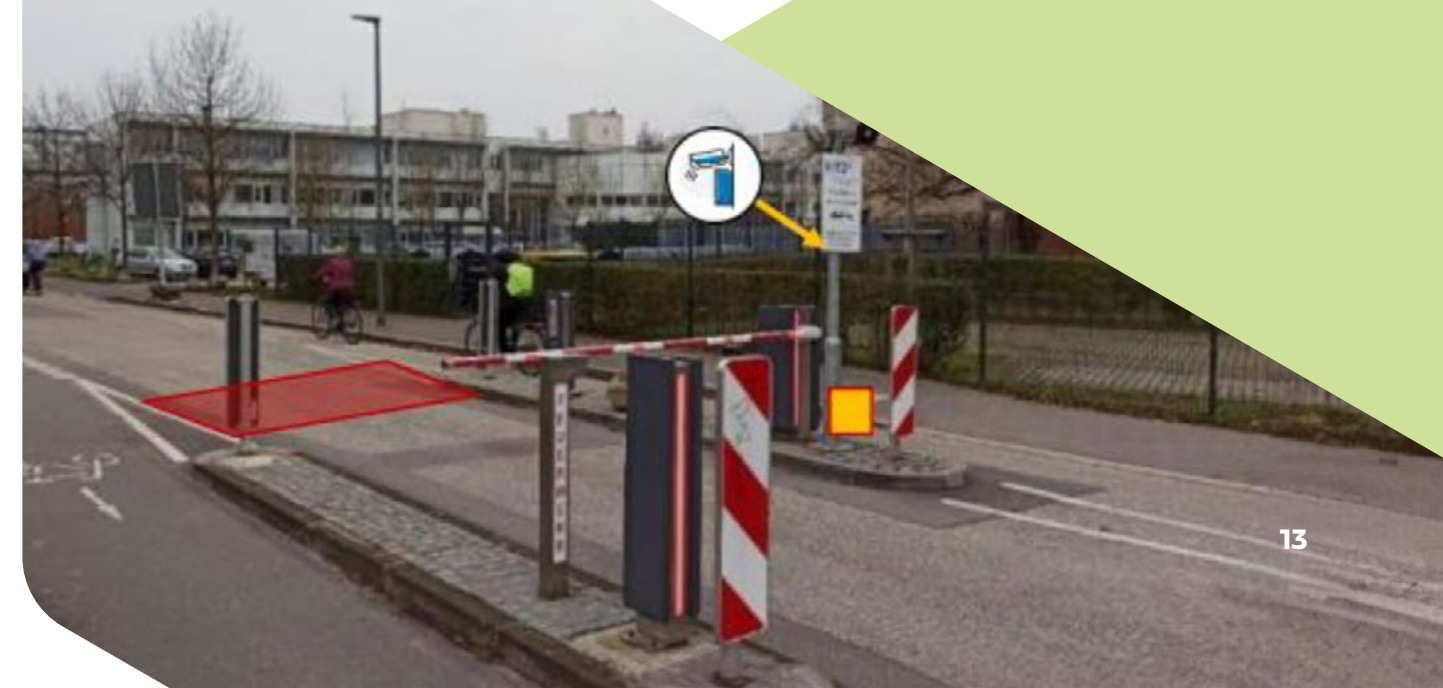
Schrankenanlage KITZ mit Montageposition Kamera & Erfassungsbereich Kennzeichen. Quelle: EDAG
